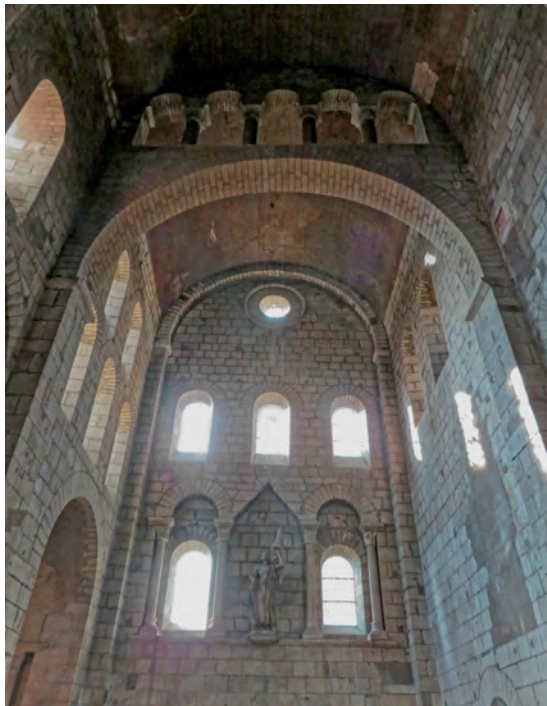
Fig. 8 : Saint-Étienne de Nevers, transept, bras sud, vue intérieure Cliché de l'auteur
