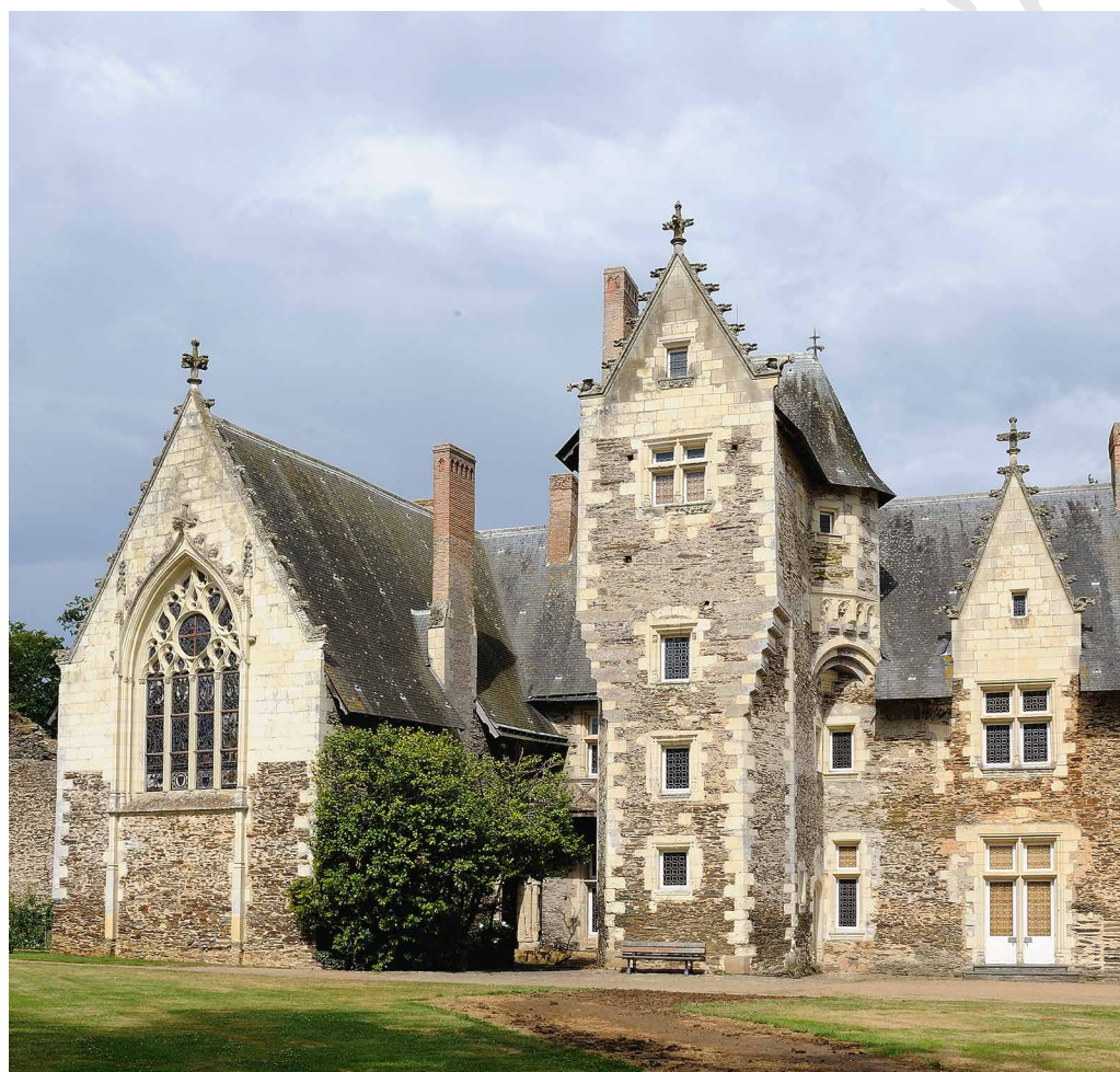
Fig. 8 – Longuenée-en-Anjou, château du Plessis-Macé, vue du corps de logis principal édifié en 1450-51d et transformé vingt ans plus tard avec l'insertion d'un plancher haut, l'adjonction d'une tour d'escalier en vis d'une chapelle.
