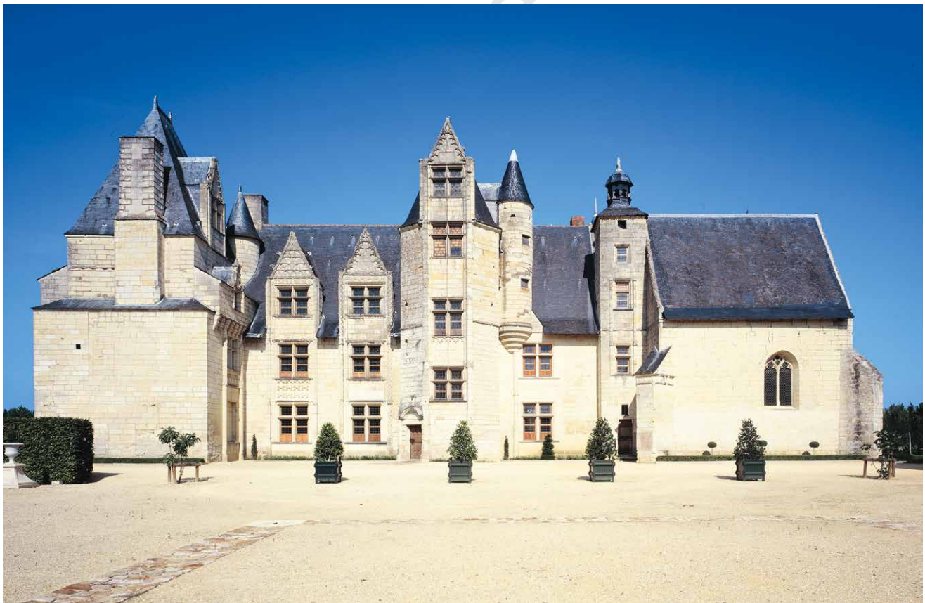
Fig. 18 – Gennes-Val-de-Loire, Saint-Martin-de-la-Place, château de Boumois, vue depuis le sud-est du corps de logis principal édifié au début des années 1520.
